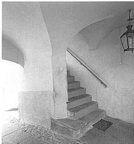
Abb. 230: San Vittore, Ca' del Gerb. Der Treppen- aufgang in der Durchfahrt, der das obere Stockwerk er- schliesst.
