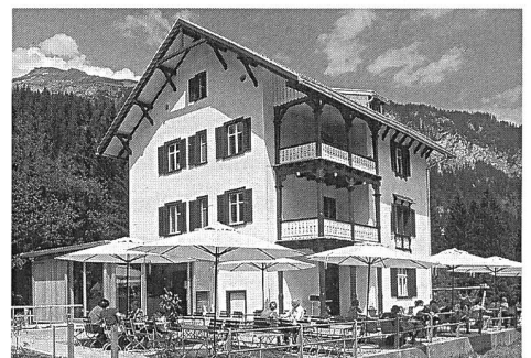
Abb. 237: Flims, Restaurant Pension Crestasee. Ansicht aus Südwesten.
