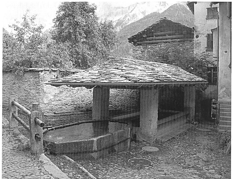
Abb. 239: Soglio, Fontana Piela. Nachzustand. Ansicht von Nordwesten.
