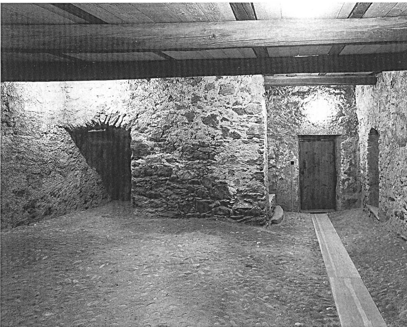
Abb. 258: Ardez, Haus Nr. 69. Die "Cuort", der Verbindungsgang im Untergeschoss. Die alte Pflasterung war zerstört und musste ersetzt werden.
