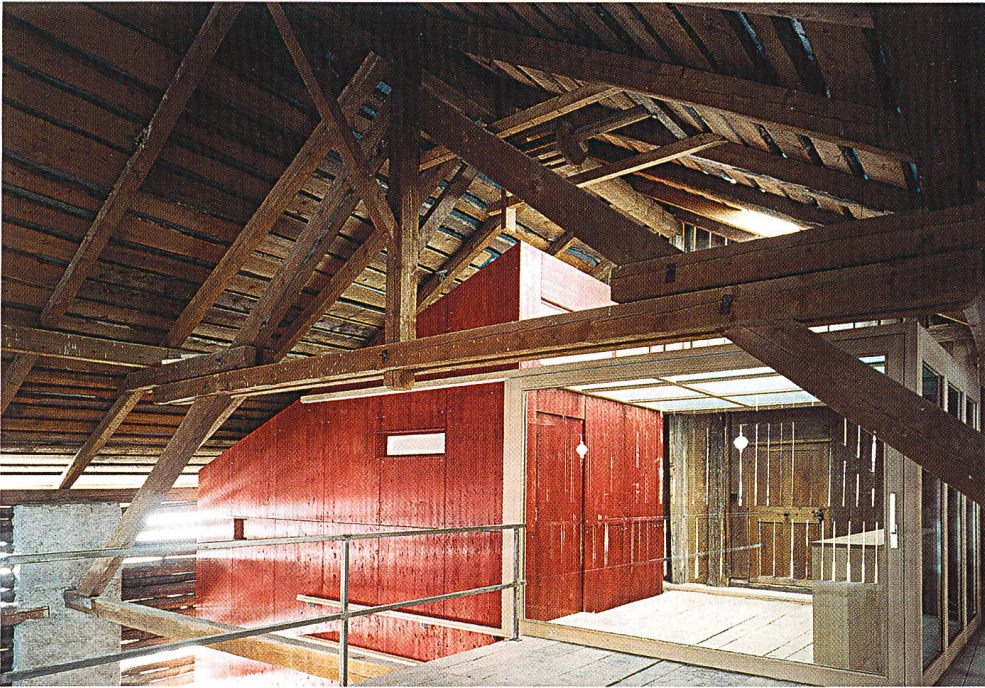
Abb. 254: Ardez, Haus Nr. 69. Das oberste Heustallge- schoss mit Blick auf den neu eingebauten „Turm“, wo die Heizung und die Sanitätsräu- me untergebracht sind. Klei- ne Öffnungen lassen gezielt Licht hinein oder sorgen für spannende Ausblicke.
