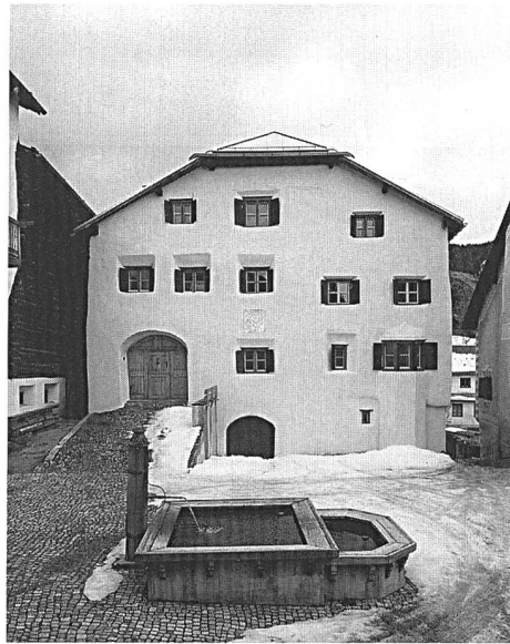
Abb. 250: Ardez, Haus Nr. 69. Platzfassade.
