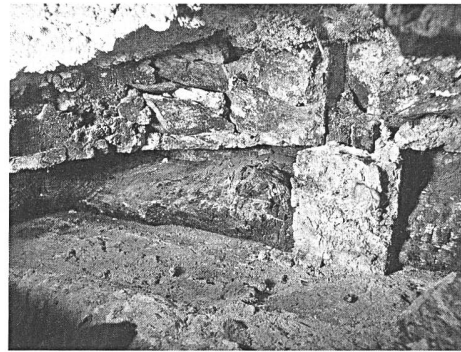
Abb. 23: Müstair, Kloster St. Johann. Karolingischer Horizontalbalken in der östlichen Giebelspitze mit einer Aussparung, darin eingemauert ein vertikales Pföstchen, das vermutlich der Bauvermessung diente. Der Balken ist 775/76 n. Chr. gefällt worden.
