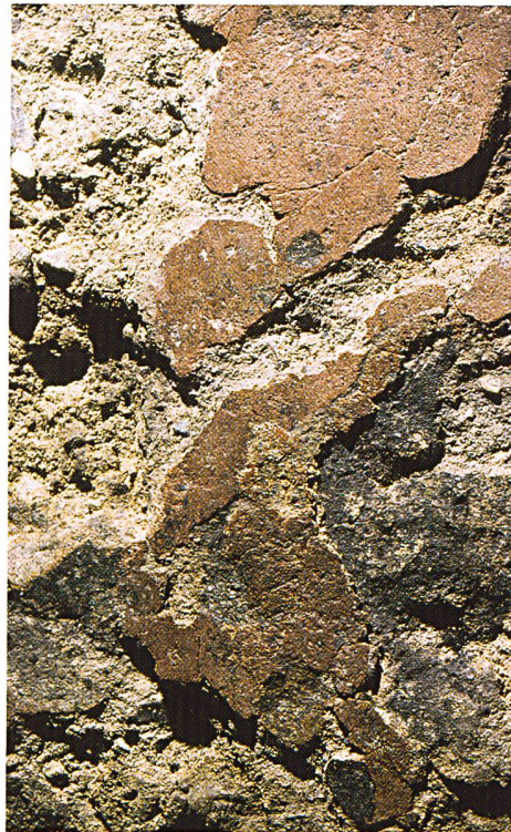
Abb. 28: Müstair, Kloster St. Johann. Sakristei 8, Detailansicht auf den mit Ziegelmehl rot eingefärbten, karolingischen Mörtelboden, darauf Spuren vom verbrannten Mobiliar (Sitzbank).
