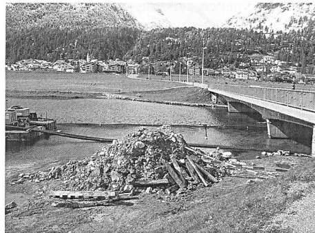
Abb. 71: Silvaplana, Brücke Surlej. Die aus dem Seegrund gerissenen und am Ostufer deponierten Balken und Bohlen. Links im Bild die schwimmende Arbeitsplattform, von der aus die Leitungen verlegt wurden. Blick gegen Norden.
