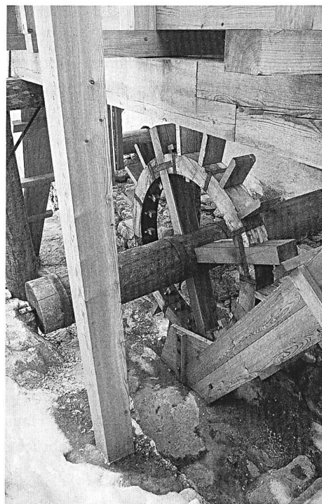
Abb. 108: Sta. Maria i. M., Mühle Mall. Instandgesetz- tes Wasserrad.
