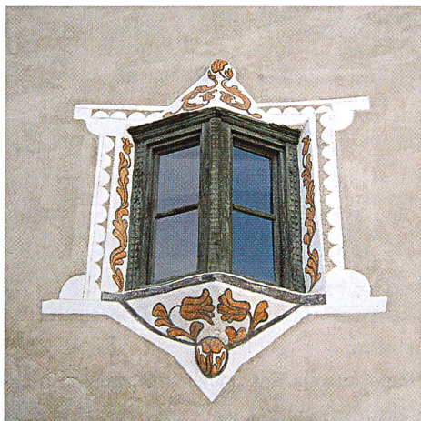
Abb. 109: Scuol, Haus Nr. 82. Details der restaurierten Fassade.
