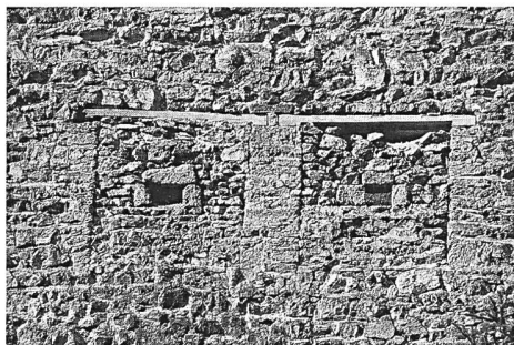
Abb. 134: Brienz/Brinzauls, Burgruine Belfort. Die nach- träglich zugemauerten Wehrfenster in der Nord- fassade.
