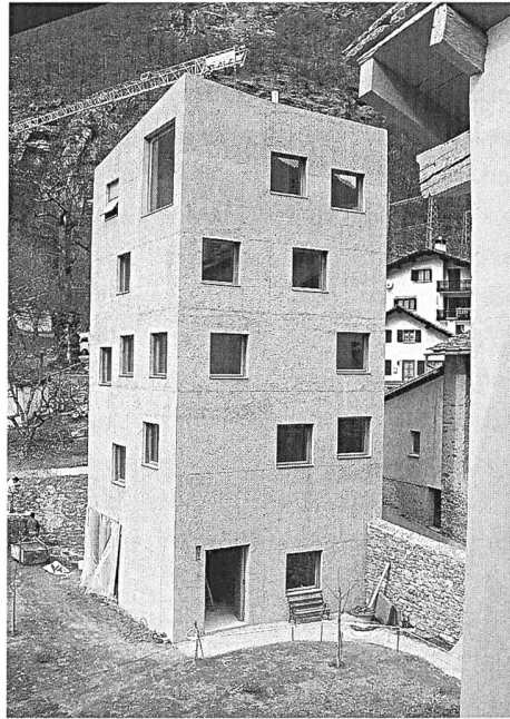
Abb. 152: Castasegna, Villa Garbald. Neubau für die ETHZ-Aussenstelle im Garten der Villa Garbald, Rohbauzustand 2003.
