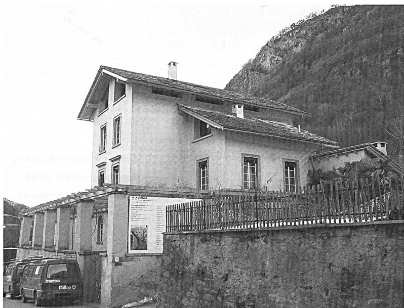
Abb. 149: Castasegna, Villa Garbald. Zustand 2003, während der Restaurierung. Ansicht von Nordosten.
