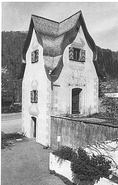
Abb. 156: Ilanz, Gartenhaus Schmid von Grüneck. Ansicht von Südwesten.
