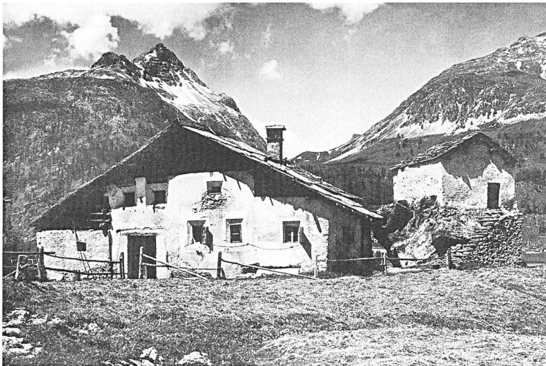
Abb. 186: Silvaplana, Surlej, Bauernhaus mit freistehendem Speicher. Das Bild zeigt die betriebliche Einheit zwischen dem Einhof mit Wohn- und Stallteil und dem freistehenden Vorratshaus. Ansicht von Osten.
