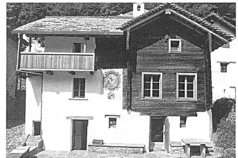
Abb. 63: Soazza, Casa San Floriano Nr. 111. Restaurierte Hauptfassade.
