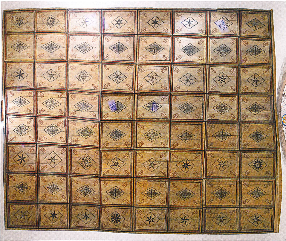
Abb. 83: Riom-Parsonz, Salaschings, Kapelle St. Bartholomäus. Felder- decke im Schiff.
