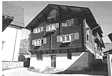
Abb. 154: Gebäudeinventar. Lumbrin, Haus Nr. 111. Südfassade.
