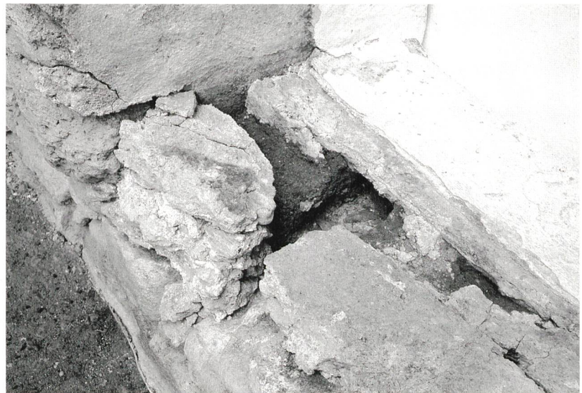
Abb. 35: Müstair, Kloster St. Johann. Westtrakt, Erdgeschoss, Kreuzgang 11w. Brüstungsmauer der südlichsten Kreuzgangarkade, Reste der jüngeren Aufmauerung, dahinter Erdschicht mit Mörtelabdeckung und Aussparung für ein Schwellenholz. Blick gegen Südosten.
