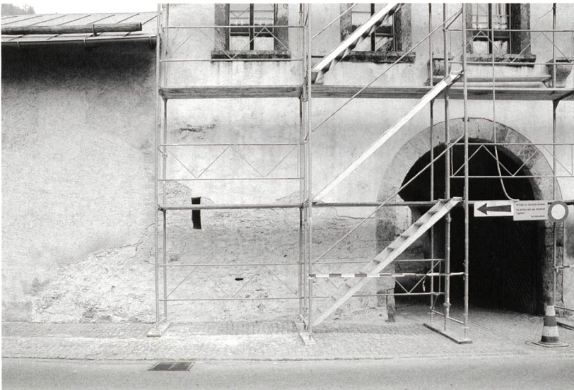
Abb. 36: Müstair, Kloster St. Johann. Südtrakt, Südtorturm, Süd- und Ostfassade. Entmörtelte Sockelpartie. Blick gegen Norden.
