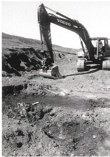
Abb. 79: Riom-Parsonz, Cadra, untere Strassenkurve. Dunkle, steinig-humose Schicht, die während der Baggerarbeiten ans Tageslicht gelangte.
