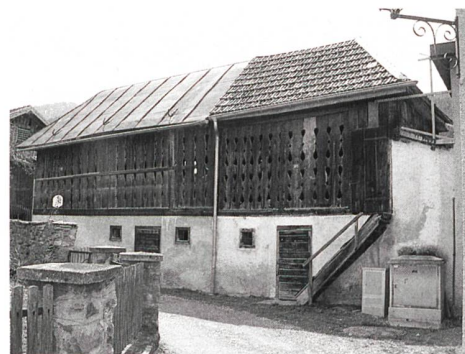
Abb. 73: Ilanz, Parzellen Nr. 192/193. Die zwei an die Stadtmauer angebauten Ställe vor dem Abbruch. Blick gegen Süden.
