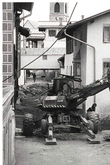
Abb. 77: Müstair, Via Imperiala. Beginn der Leitungssanierung. Blick gegen Norden.
