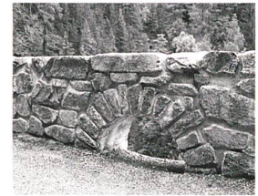
Abb. 137: Davos, Filisur, Wiesen, Alte Zügenstrasse. Bogenbrücke über den Sägenbach nach der jüngsten Instandstellung. Ersatz der fehlenden Brüstung nach historischem Vorbild.
