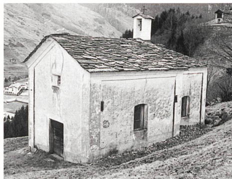
Abb. 165: Vals, Soladüra, Kapelle St. Johannes Baptist. Blick gegen Südosten. Vor- zustand.
