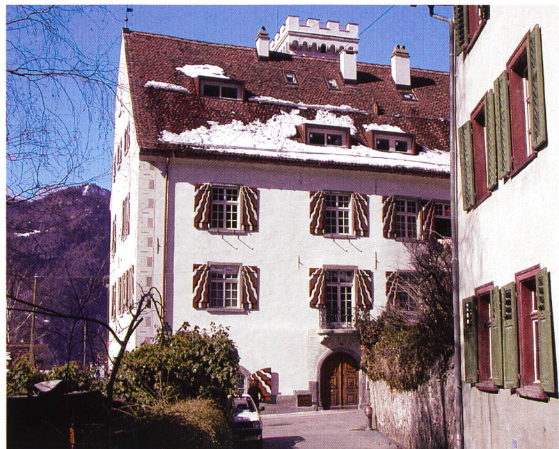
Abb. 143: Malans, Haus «zum grünen Turm» Nr. 74. Blick gegen Westen. Nachzustand.
