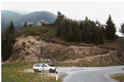
Abb. 93: Sumvitg, Chischliun. Ansicht des Hügels, nachdem die Baumaschine das Wegtrasse in die Hügel- flanke gegraben hat. Blick gegen Süden.
