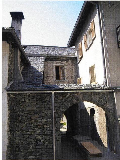
Fig. 134: Grono, casa no. 198 alla «Torr». Portico d'entrata.
