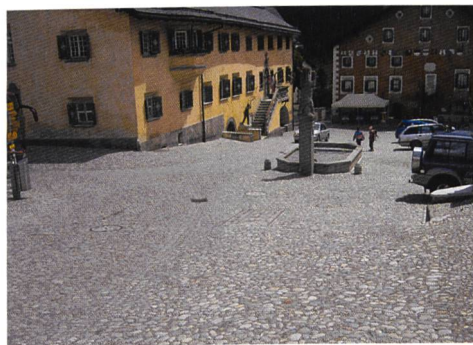
Abb. 146: Zuoz, «Plaz», nach dem Neusetzen der Pflasterung.
