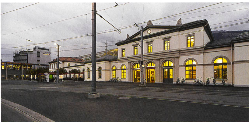
Abb. 129: Chur, Bahnhofsgebäude. Blick gegen Westen. Nachzustand.
