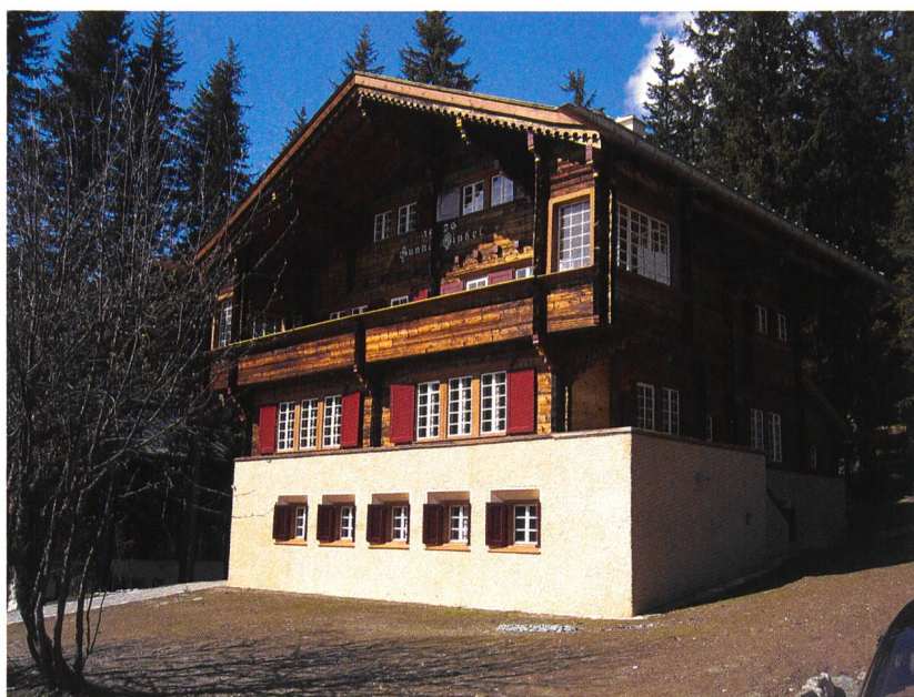
Abb. 116: Arosa, Chalet «Sunnawinkel» Nr. 831. Blick gegen Nordosten. Nachzustand.
