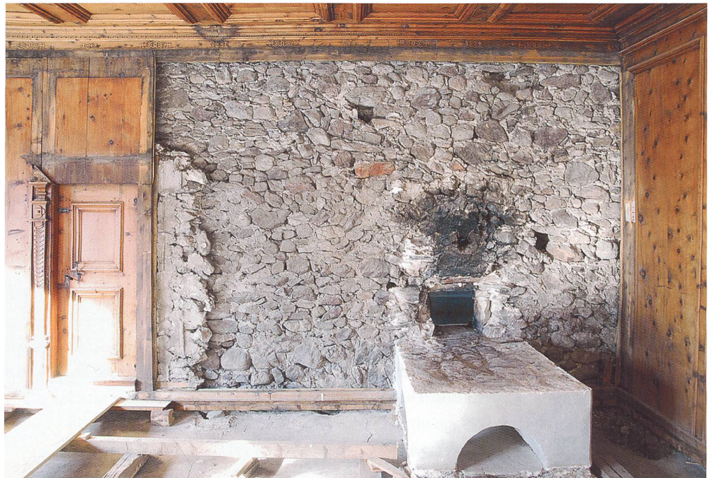
Abb. 55: Val Müstair, Müstair, Kloster St. Johann. Norpertrakt 2. Obergeschoss, Fürstenzimmer 143. Ehemalige nördliche Giebelwand mit Dachschräge; die darauf liegenden Lattenlöcher gehören zu einer Dachdeckung von 1405. Blick gegen Norden.
