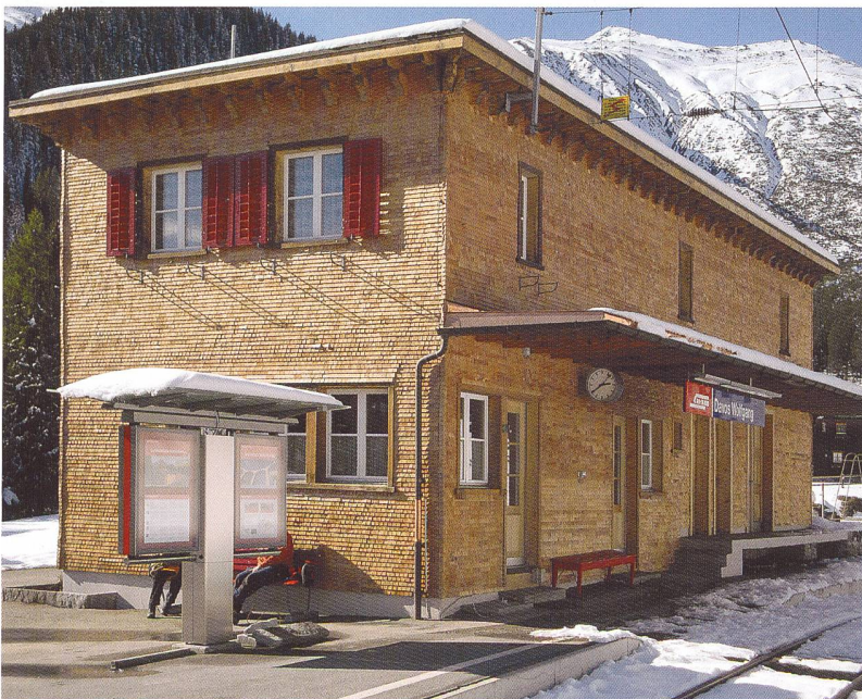
Abb. 136: Davos, Wolfgang, Bahnstation der RhB, Nr. 471. Ansicht von Osten nach der Erneuerung des Schindelschirms.
