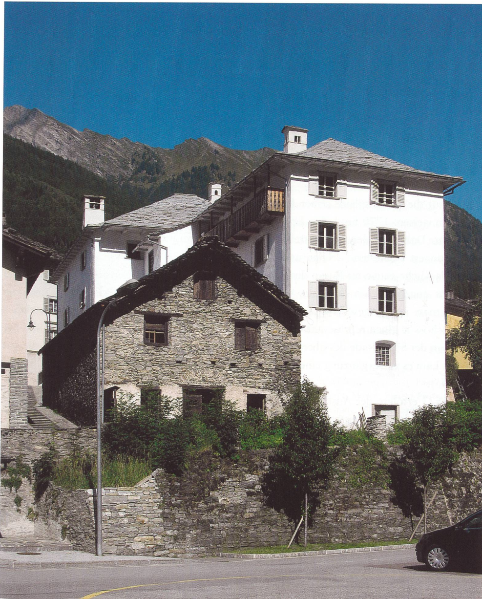
Abb. 144: Mesocco, Casa a Marca di Sotto, Nr. 89. Ansicht von Südosten, links der Pferdestall.
