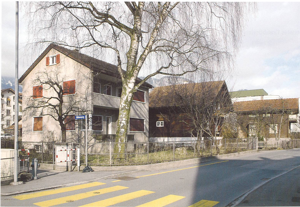
Abb. 169: Igis, Landquart, Abbrüche im Raum Bahnhofstrasse. Die Wohnhäuser Nr. 311, 312 und 312A an der Zollstrasse vor dem Abriss. Ansicht von Südwesten.
