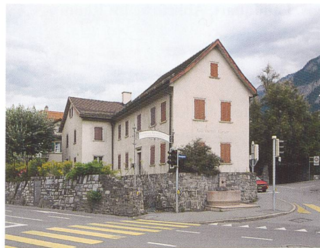
Abb. 165: Chur, Masanserstrasse 120, «Zum Deckten Bränneli». Ansicht von Südwesten.
