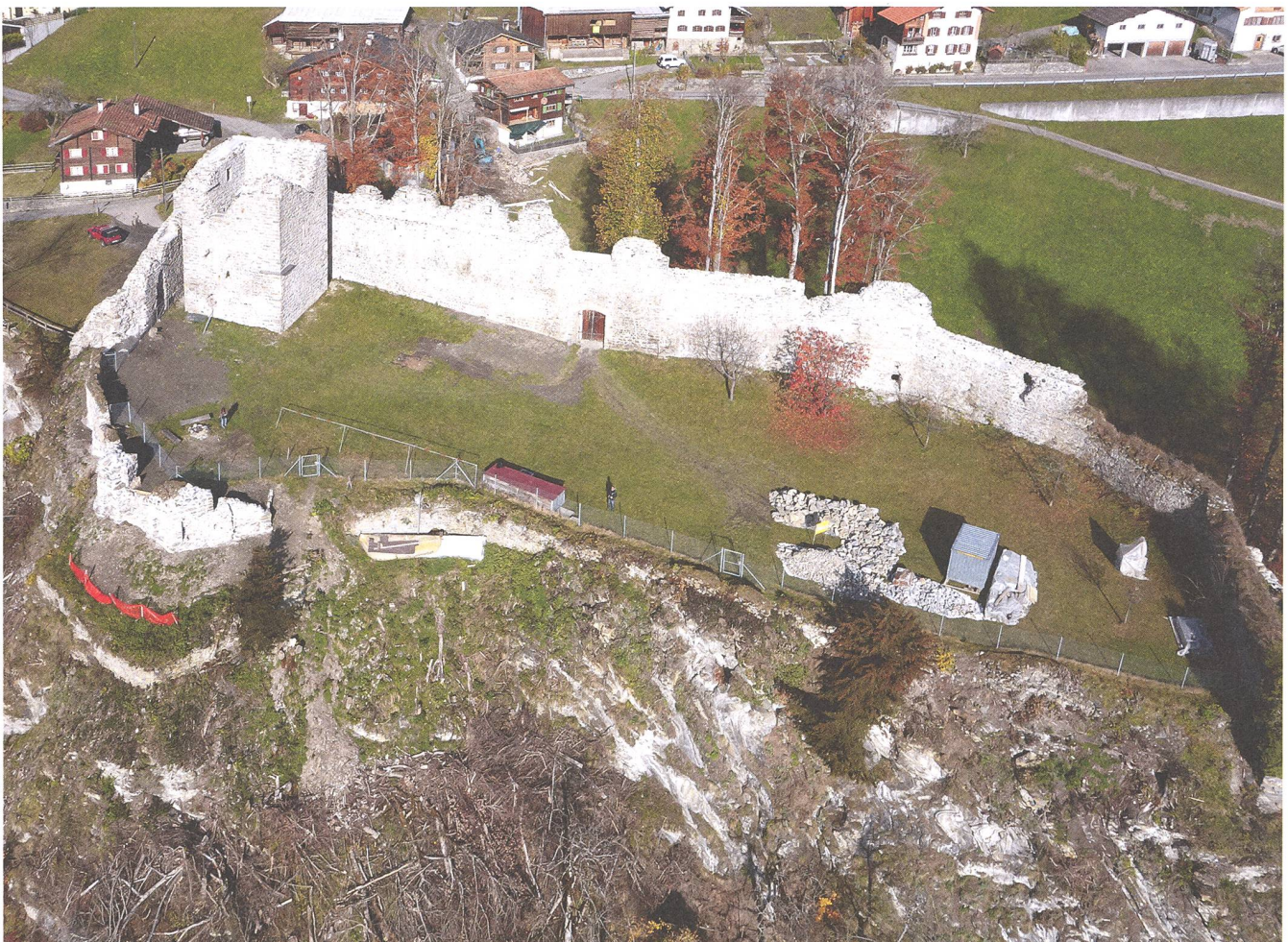
Abb. 1: Luzern, Putz, Buranlage Castels. 2015. Die in den Jahren 2011–2014 restaurierten Mauerabschnitte heben sich deutlich von den noch ungesicherten Partien ab. Blick gegen Norden.
