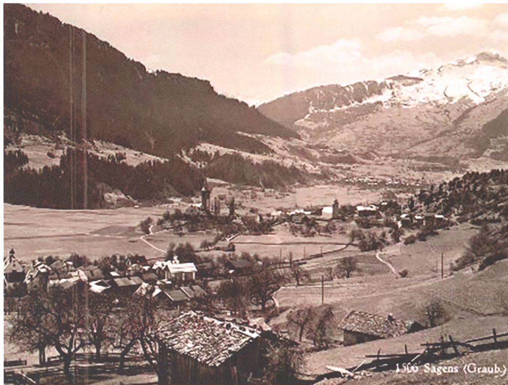
Abb. 26: Sagogn mit seinen beiden Dorfteilen Vitg Dado vorne links und Vitg Dadens in der Bildmitte. Im Hintergrund die Stadt Ilanz. Blick über die Gruob gegen Westen. Fotografie (Ansichtskarte) von Jules Geiger, 1934.
