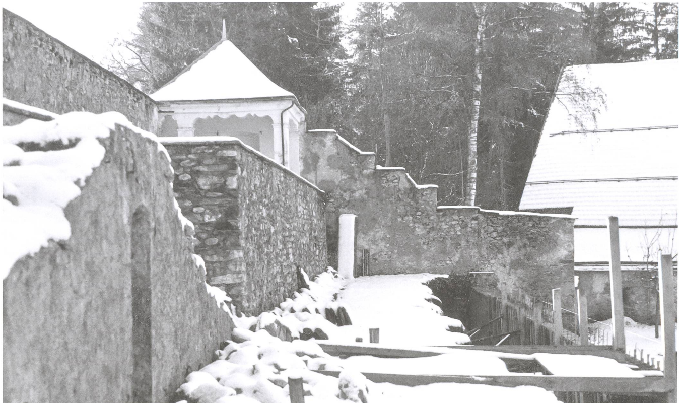
Abb. 1: Sils i. D., Palazzo Donatz, Garten. 1974/75. Renovierungsarbeiten im Bereich der Treppenanlage. Blick gegen Westen.
