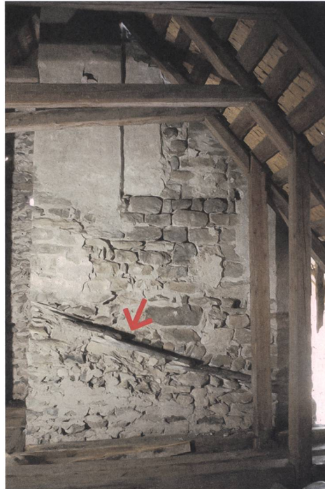
Abb. 13: Breil/Brigels, Sogn Sievi. 1970–1972. Dachgeschoss. Eine Reihe vorkragender Steinplatten (Pfeil) an der Turmostwand zeigt die Dachneigung von Bau I an. Blick gegen Westen.
