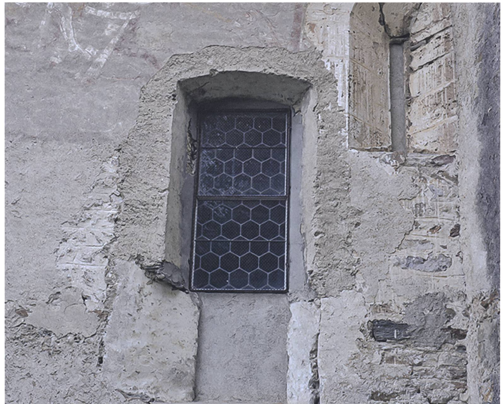
Abb. 32: Rhäzüns, Sogn Gieri. 2019. Ausschnitt der Südfassade des Schiffes mit sichtbarem älterem Mauerwerk und rundbogigem Schiffsfenster von Bau IV. Bildmitte: Jüngerer, mehrfach verändertes Fenster. Blick gegen Norden.
