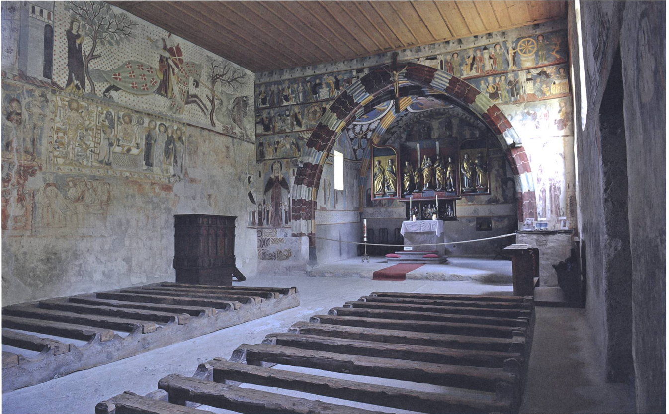
Abb. 2: Rhäzüns, Sogn Gieri. 2019. Der Innenraum der Kirche. Blick gegen Nordosten.
