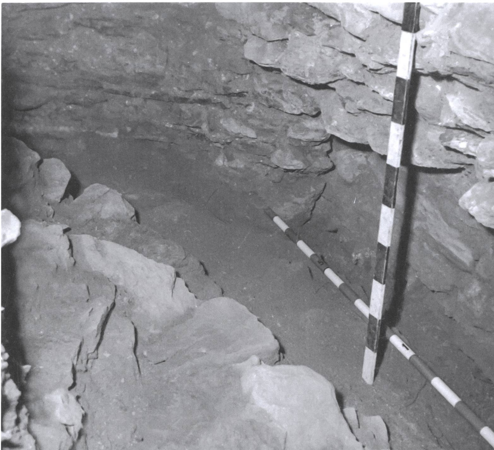
Abb. 11: Rhäzüns, Sogn Gieri. 1961. Fundament der Apsis von Bau I. Blick gegen Nordosten.
