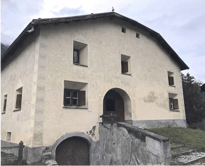
Abb. 2: S-chanf, Cinuos-chel, Chesa Giorgio. Ansicht der Westfassade im Jahr 2019. Unter der Zufahrt zum Haus lag der unbekannte und mit dem Keramikinventar verfüllte Keller. Blick gegen Südosten.
