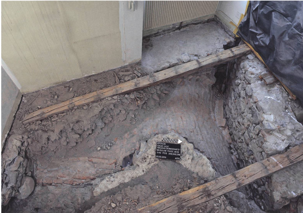
Abb. 4: Chur, Hof, Bischöfliches Schloss, Etappe 3, 2019. Im Raum über dem Museumseingang wurde das barocke Gewölbe freigelegt. Die Fototafel liegt auf dem gegen den Hofplatz abgebrochenen, spätgotischen Kreuzgewölbe. Daran schliesst im Westen das barocke Tonnengewölbe an. Blick gegen Westen.
