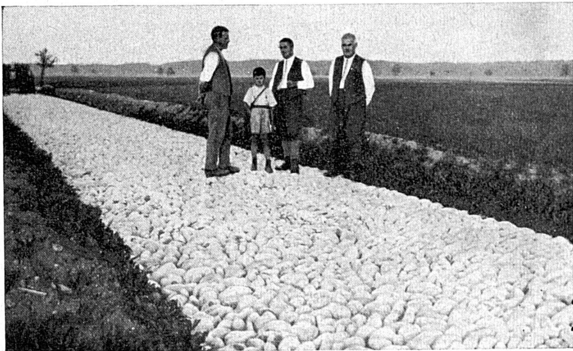
Un nouveau chemin avec une chaussée solidement empierrée.
