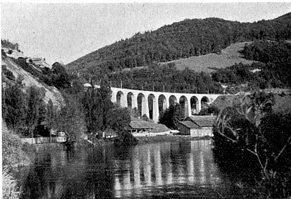
Le Viaduc de St-Ursanne
