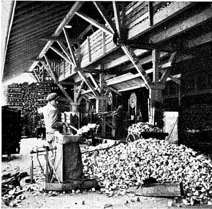
Préparation du bois carburant. (Chantier de l'entreprise Losinger et Cie, Delémont.)
