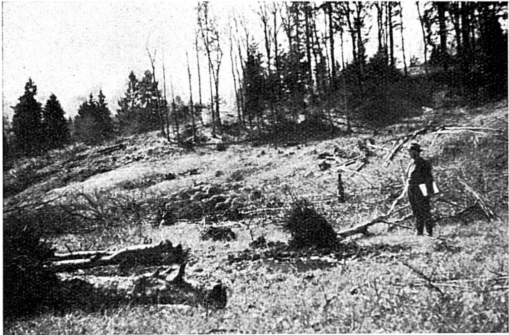
Le défrichement du pré Borbet à Bassecourt. Les arbres et les arbrisseaux sont abattus. Ensuite, le sol sera aplani et drainé. Aujourd'hui, ce domaine est ensemencé et labouré. Le sol, marécageux et couvert de broussailles autrefois, a été transformé en terrain cultivable.
