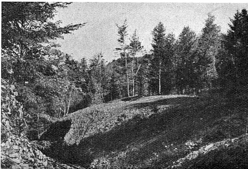
Les déblais du tunnel sont constitués surtout par de la marne. Ils ont fourni la masse de remplissage du puits.
