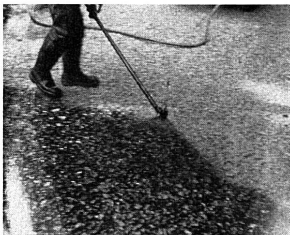
Epandage de « Composol A » à chaud
