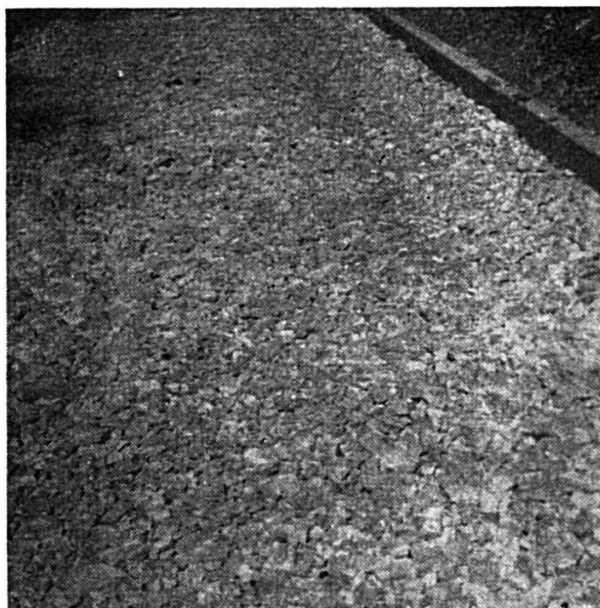
Deuxième couche de chaille compactée
