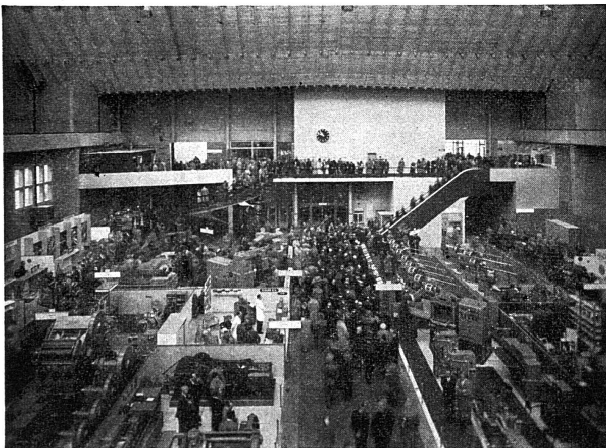
La dernière en date des halles de la Foire Suisse d'Echantillons de Bâle, réservée en 1958 aux machines-outils, abritera en 1959 une section de manutention rationnelle.
