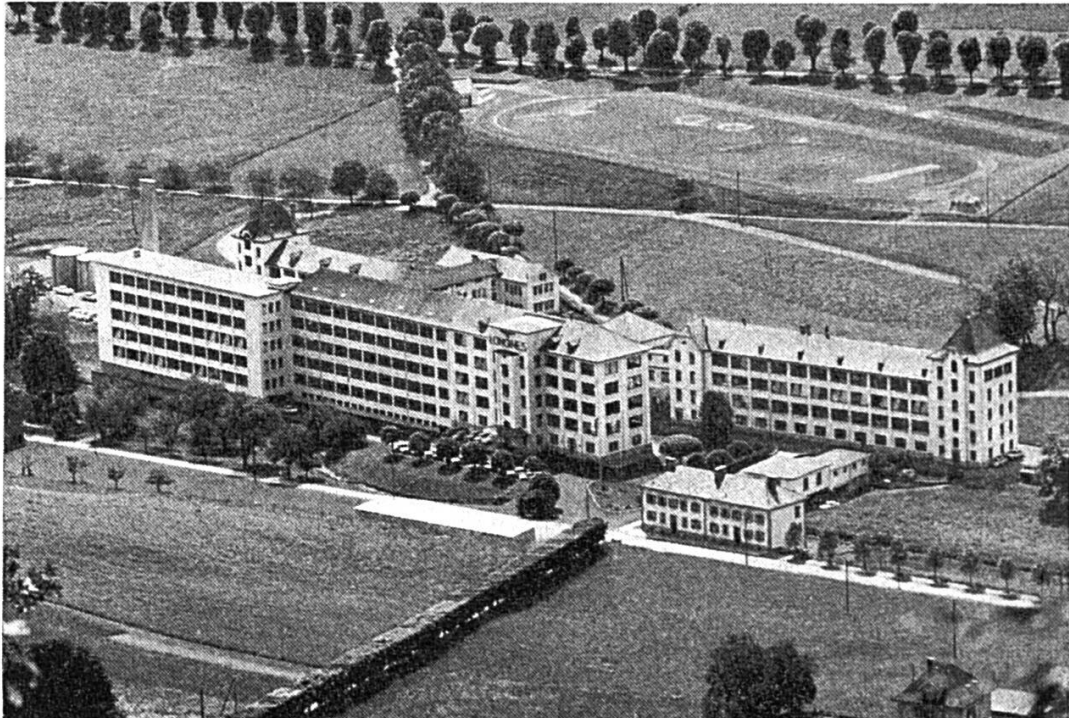
L'actuelle fabrique principale des Longines, à Saint-Imier.
