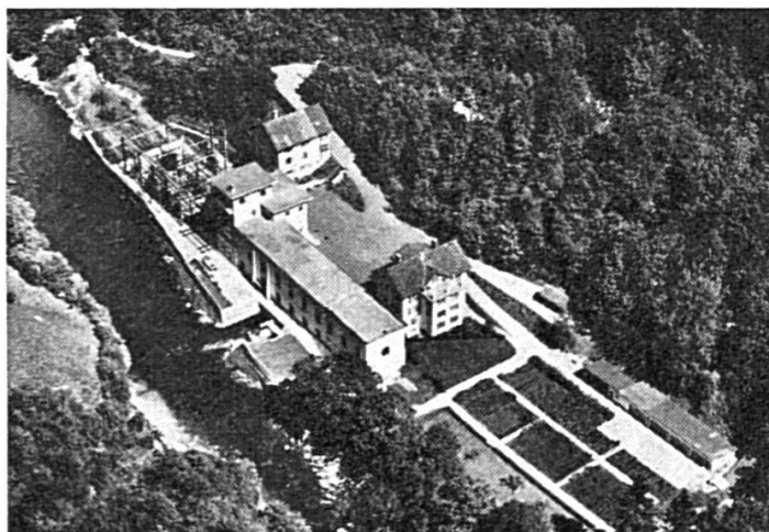
USINE DE LA GOULE SUR LE DOUBS
