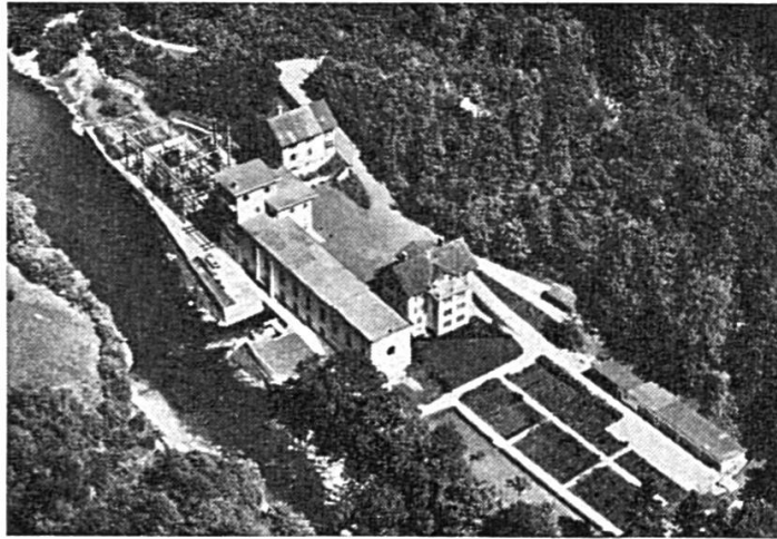
USINE DE LA GOULE SUR LE DOUBS
