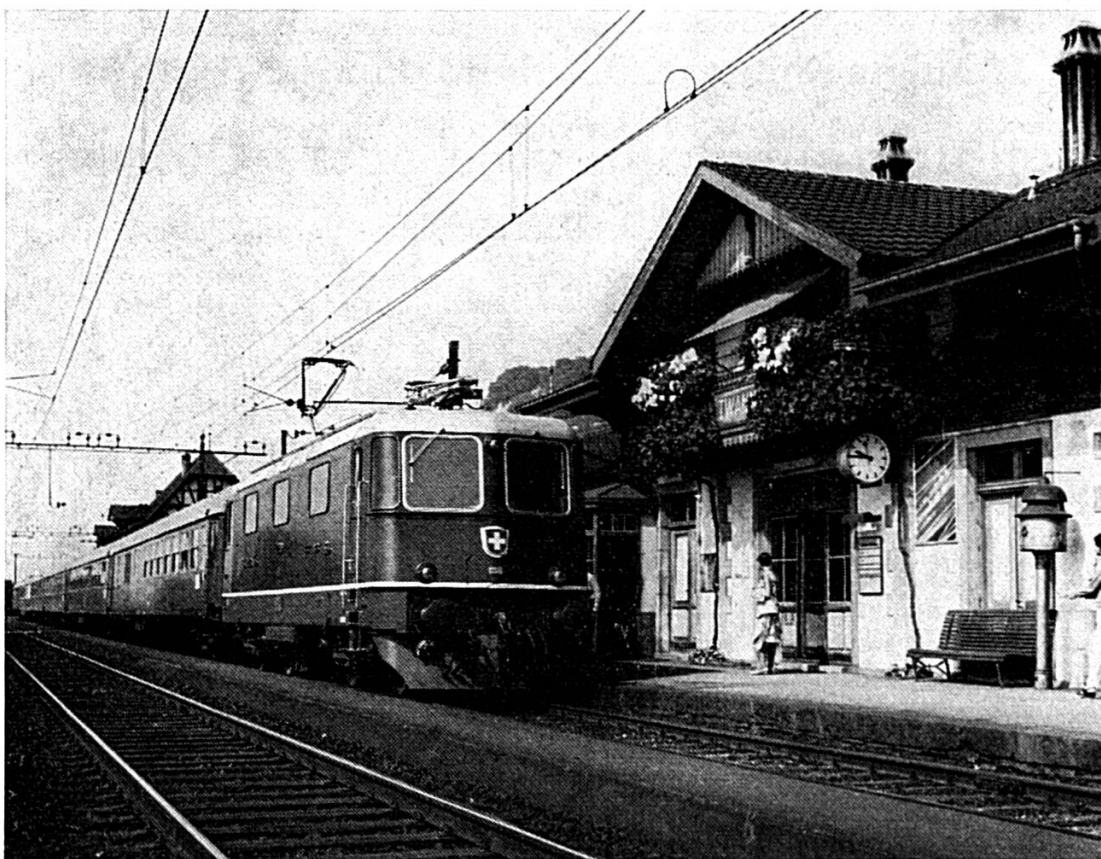
Le train « Hispania-Express » passant en gare de Twann. Ce bâtiment entouré de lierre et de fleurs va disparaître pour permettre la construction de la route nationale 5. La nouvelle gare sera édifiée plus près du lac.
