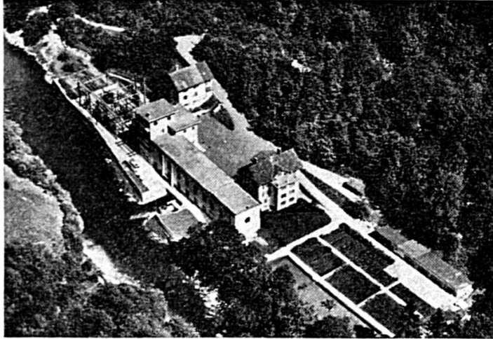
USINE DE LA GOULE SUR LE DOUBS
