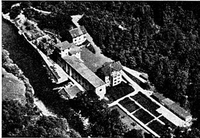
USINE DE LA GOULE SUR LE DOUBS
