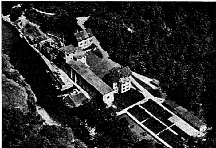
USINE DE LA GOULE SUR LE DOUBS
