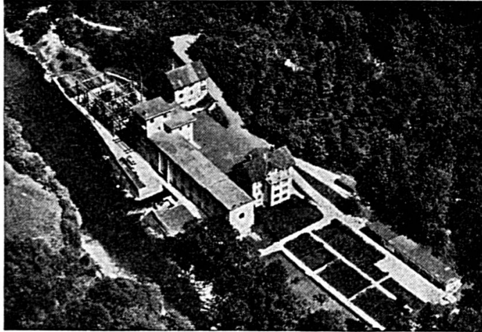
USINE DE LA GOULE SUR LE DOUBS
