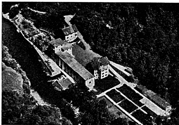
USINE DE LA GOULE SUR LE DOUBS
