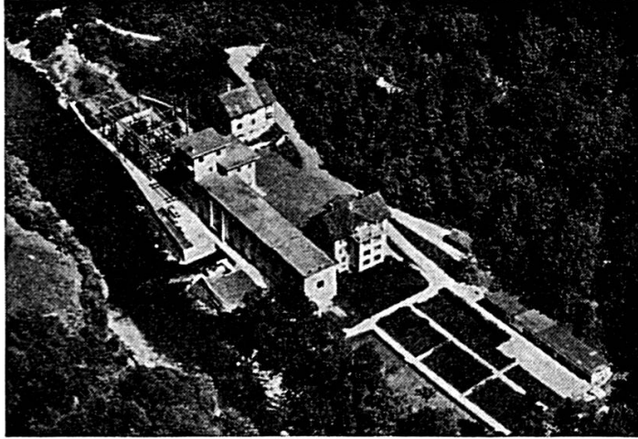
USINE DE LA GOULE SUR LE DOUBS
