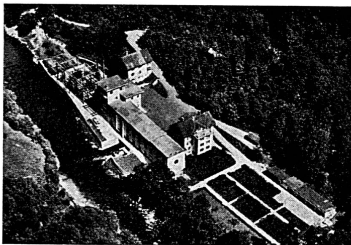
USINE DE LA GOULE SUR LE DOUBS
