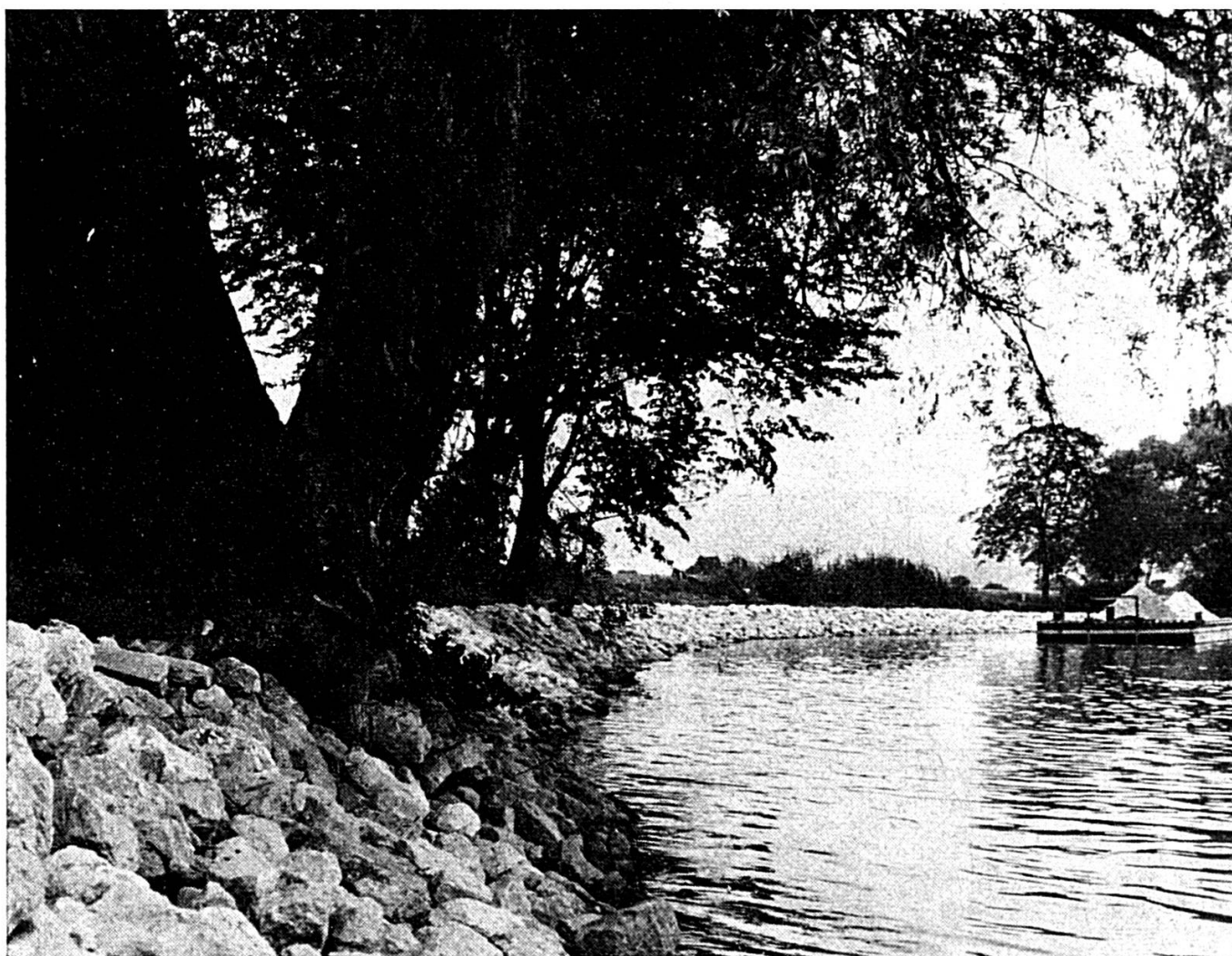
Aar Büren-Soleure : protection des rives à Leuzigen.
