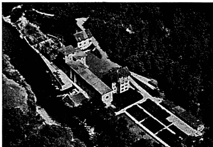
USINE DE LA GOULE SUR LE DOUBS
