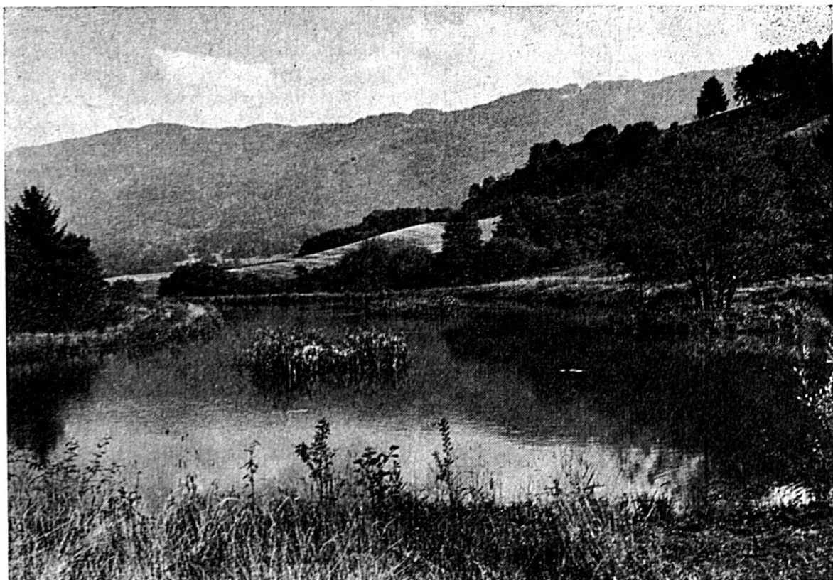
Etang des Chaux-Fours après les travaux ; à gauche la digue.
