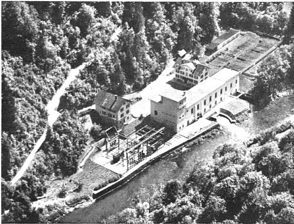
USINE DE LA GOULE SUR LE DOUBS
